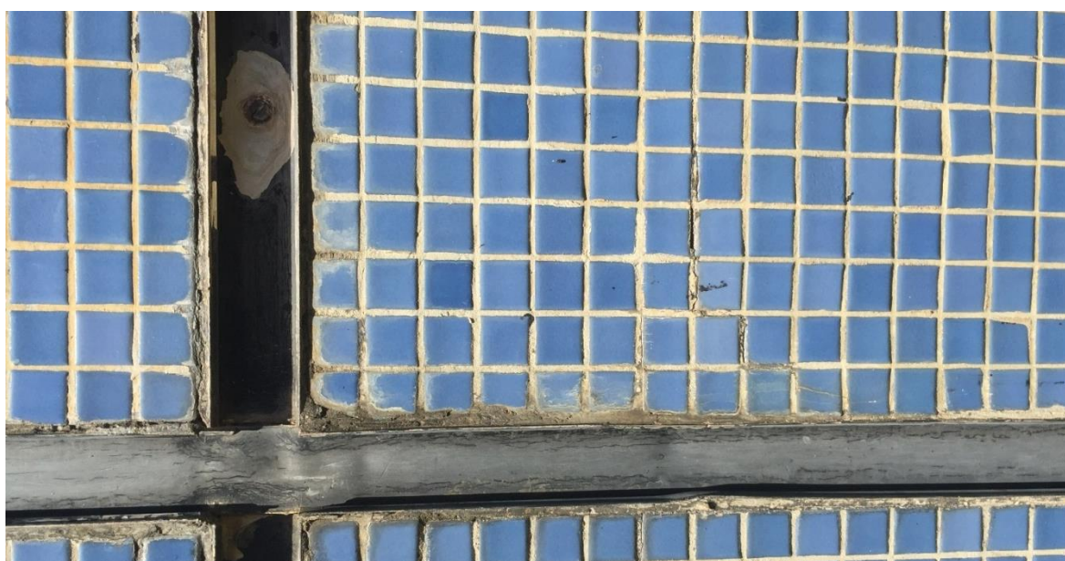
Figura 7.11: utilização de perfil metálico em forma de calha.
