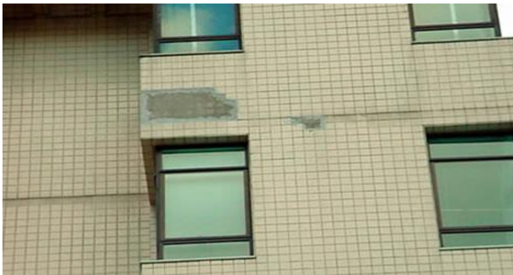
Figura 2.3: destacamento de pastilhas. Fonte: http://www.fchconsultoria.com.br .
