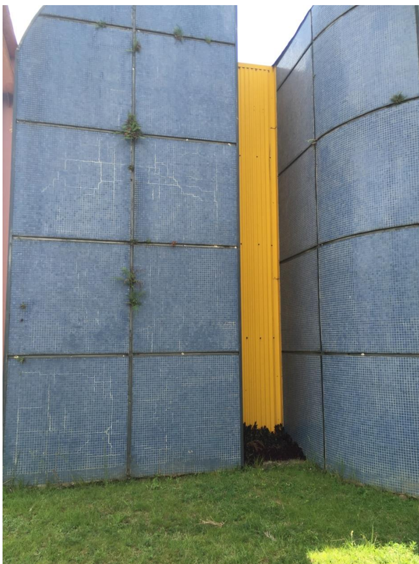
Figura 7.1: apresentação da fachada principal da Escola de Minas.
