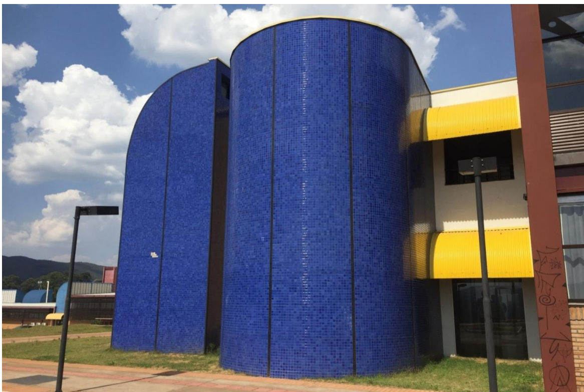
Figura 7.16: fachada da edificação mais recente do prédio da Escola de Minas.
