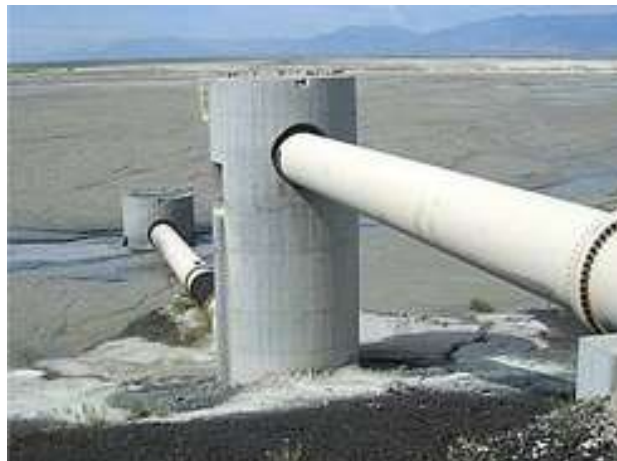
Figura 11 - Caixas de armazenamento de água na barragem da mina de cobre Kennecott, localizada nos EUA (ENGELS, 2006).
