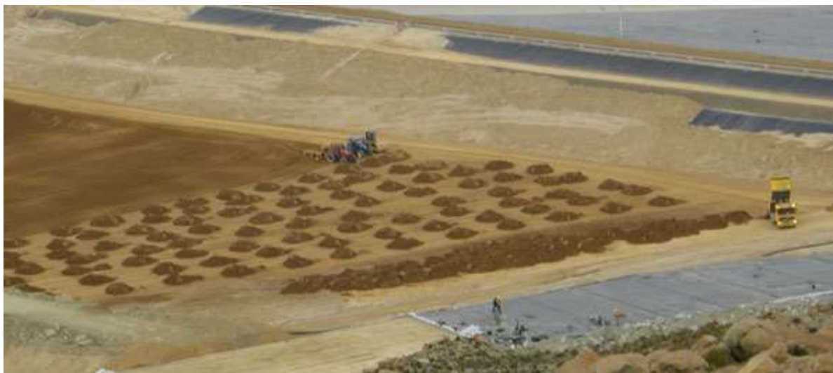
Figura 23 - Empilhamento a seco de rejeitos usando caminhões como transporte (ENGELS, 2006).
