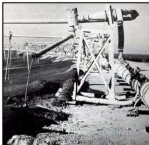
Figura 19 - Série de hidrociclones localizados na crista de uma barragem (FIGUEIREDO, 2007).
