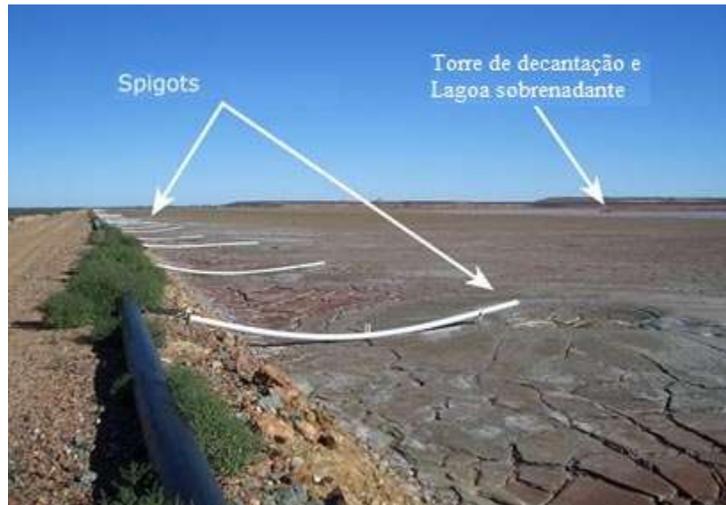
Figura 2 – Descarga de rejeitos por múltiplos pontos na mina de ouro de Jundee, Austrália (ENGELS, 2006).
