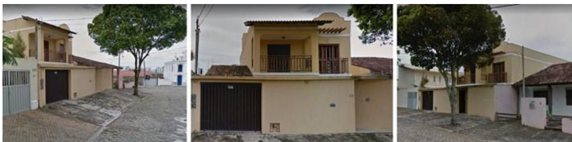
Figura 3.1 – Vistas da edificação
