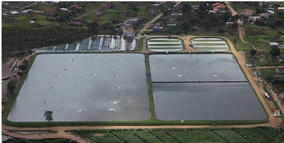
Figura 13: ETE Ponte dos Leites, em Araruama
