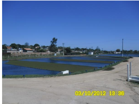
Figura 16: Lagoa de sedimentação
