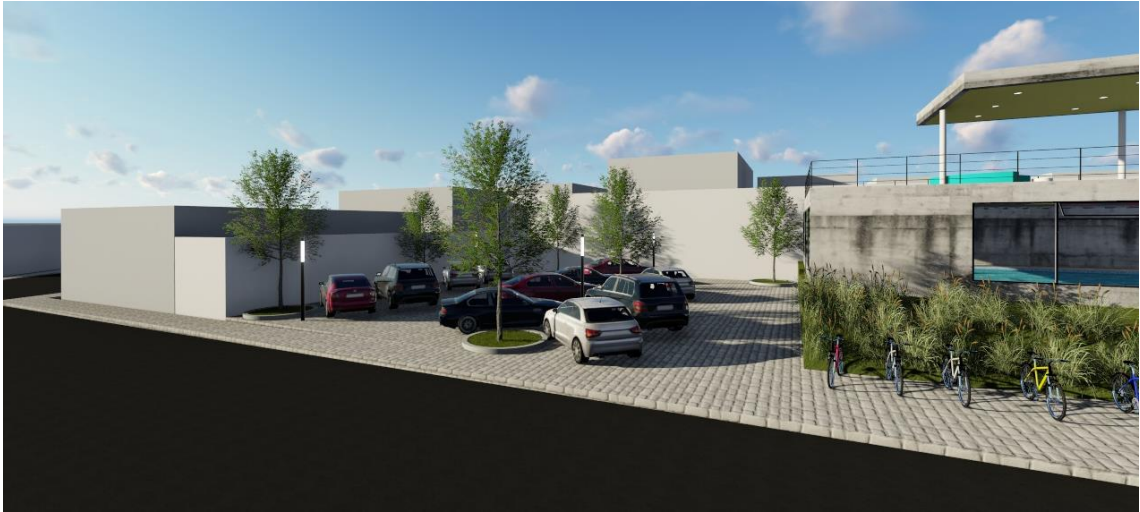
Figura 38. Estacionamento. Autoria própria.
