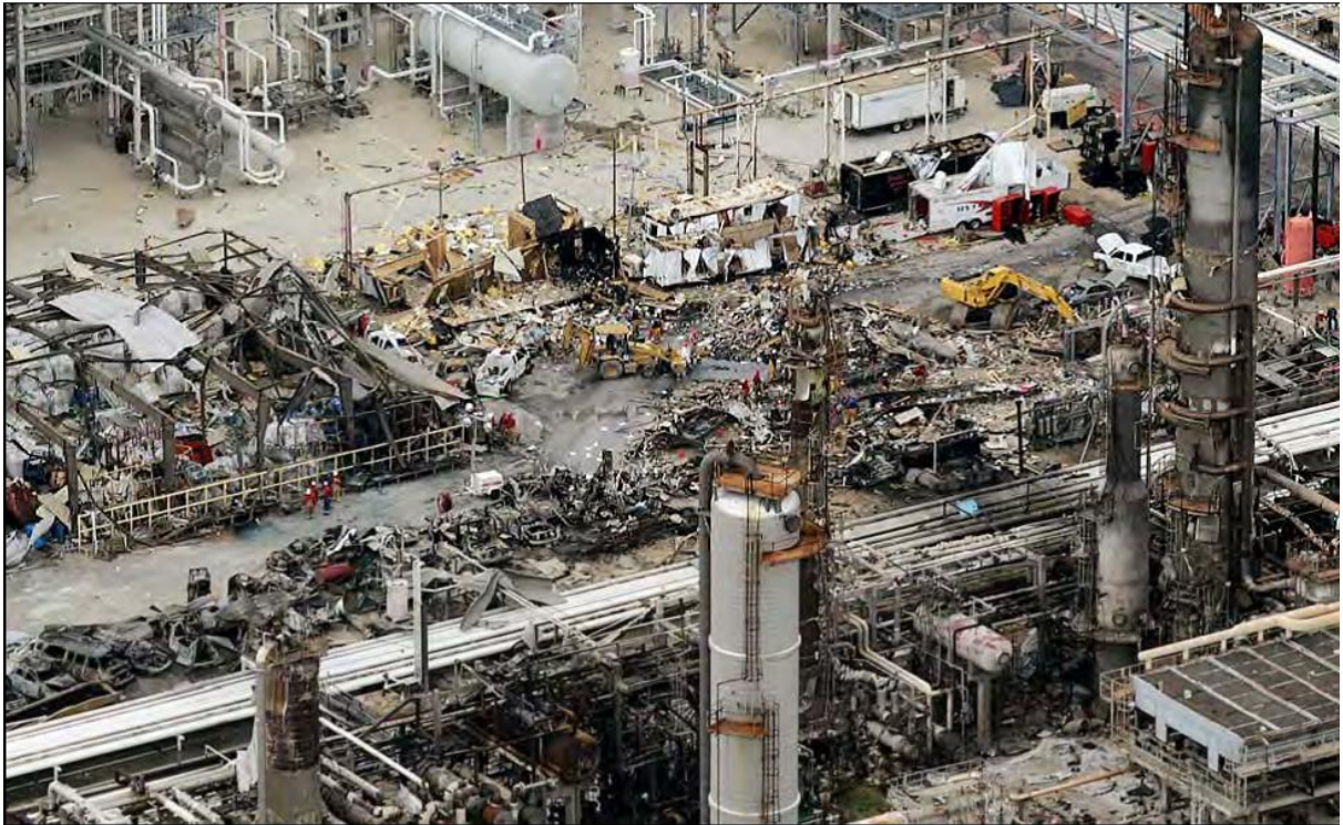
Figura 7: Visão dos estragos causados por explosões e incêndios na Refinaria BP Texas Fonte: U.S. Chemical Safety and Hazard Investigation Board, 2017.
