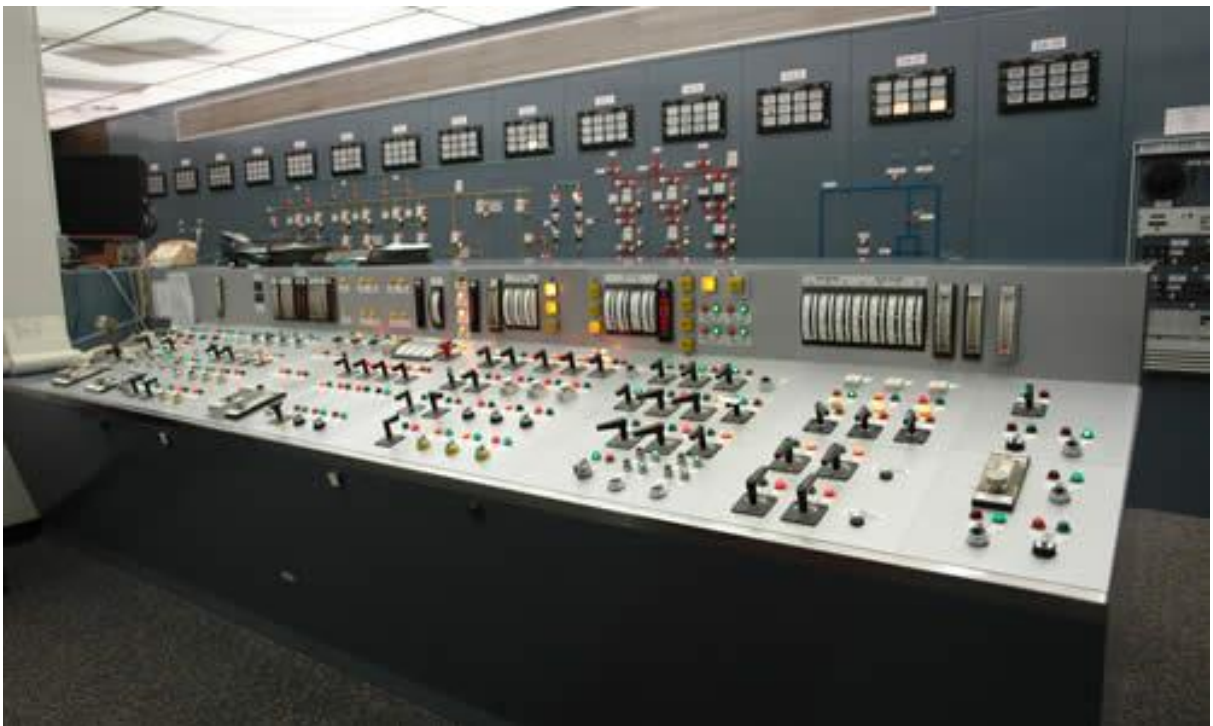
Figura 1: Painel com botoeiras e LEDs utilizado para controle de processos de manufatura Fonte: IHM: Saiba quais os Tipos e como Selecionar - Citisystems
