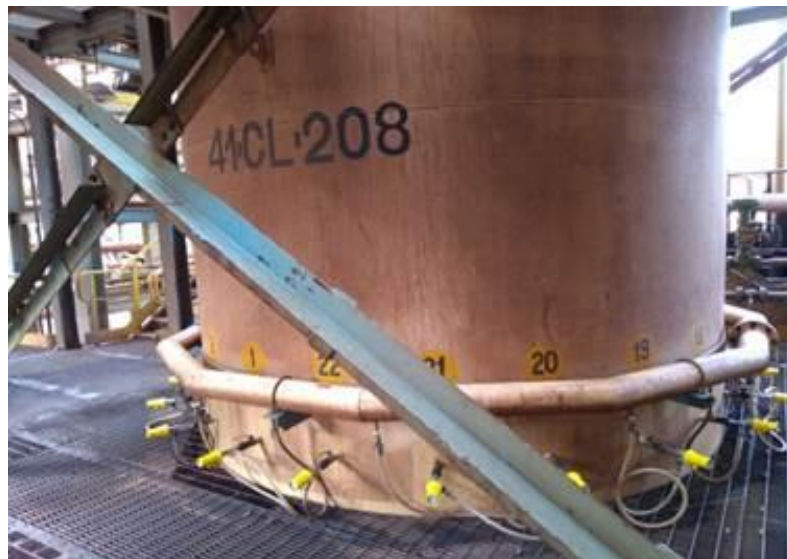
Figura 17-Aerador em teste instalado na coluna Rougher CL208
