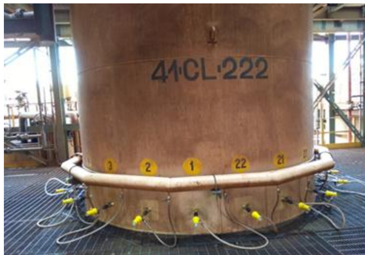
Figura 18 -Aerador em teste instalado na coluna Rougher CL222
