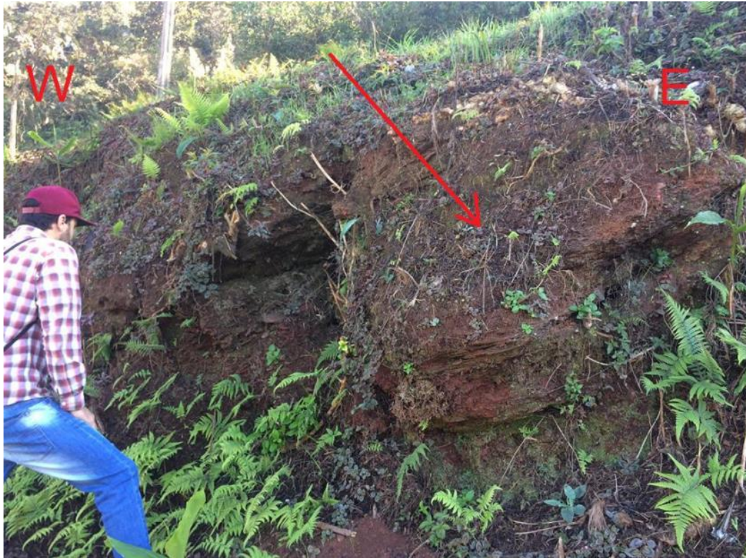
Figura 9.10 - Matações caracterizam movimentos de massa do tipo queda de blocos no topo da serra. Na figura são observados famílias de juntas que promovem o movimento. (Observação em P8 no mapa de pontos – Fig 7.1)
