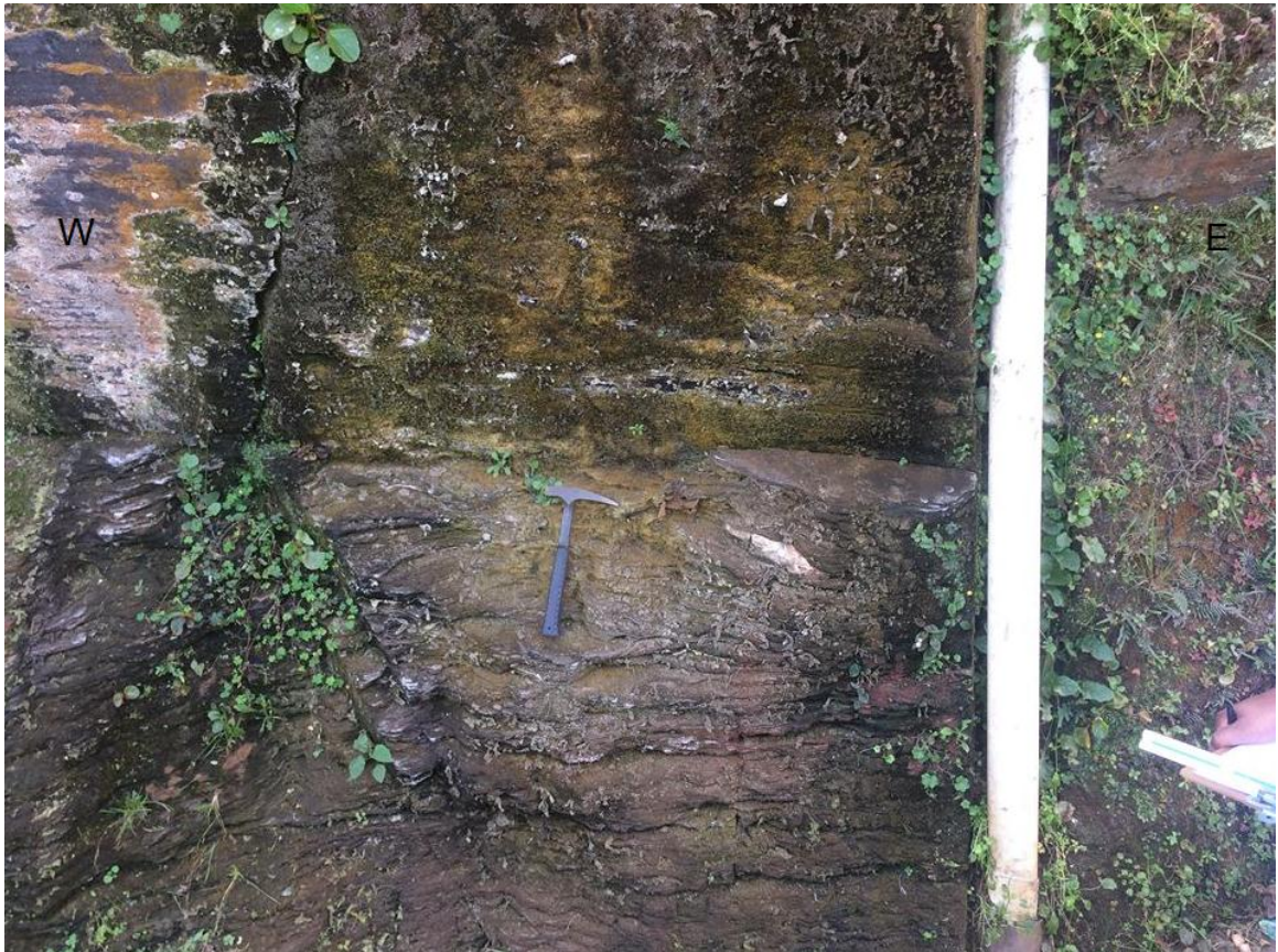
Figura 9.9 - Encanamento mal acondicionado próximo ao afloramento de itabirito mostra influência antrópica como fator condicionante para as condições de estabilidade do maciço. (Observação em P1 no mapa de pontos – Fig 7.1)
