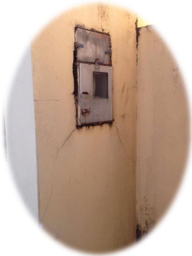
Figura 17: Foto do Ramal de entrada com enquadramento total.
