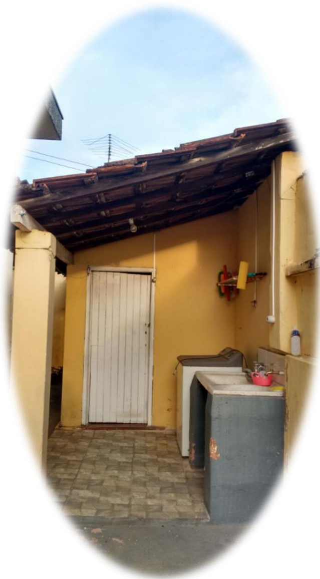
Figura 16: Local da instalação dos inversores de frequência.
