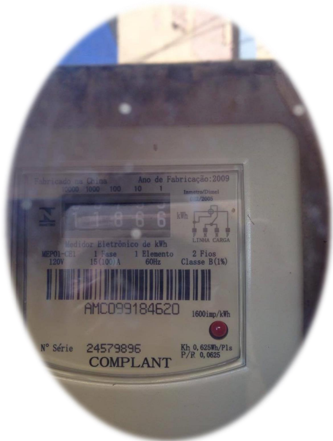
Figura 19: Medidor utilizado na unidade consumidora em São Sebastião do Paraíso.
