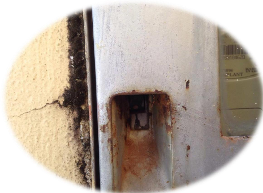
Figura 18: Foto com enquadramento do Disjuntor geral do ramal de entrada.
