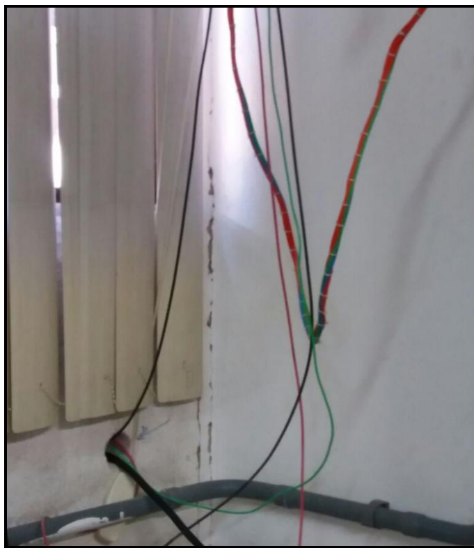
Figura 4:Trinca vertical em parede/estrutura
