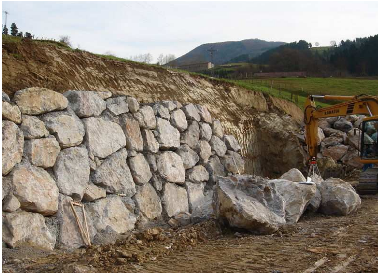
Figura 10 – Muro de pedras.
