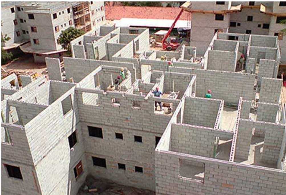
Figura 2.4 - Construção de um edifício em alvenaria estrutural
