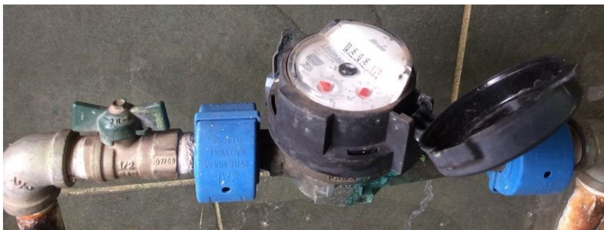
Figura 13: Hidrômetro.
