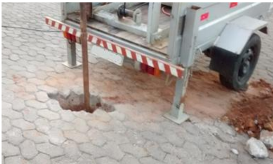
Figura 18 – Realização das sondagens Fonte: Elaborada pelo autor
