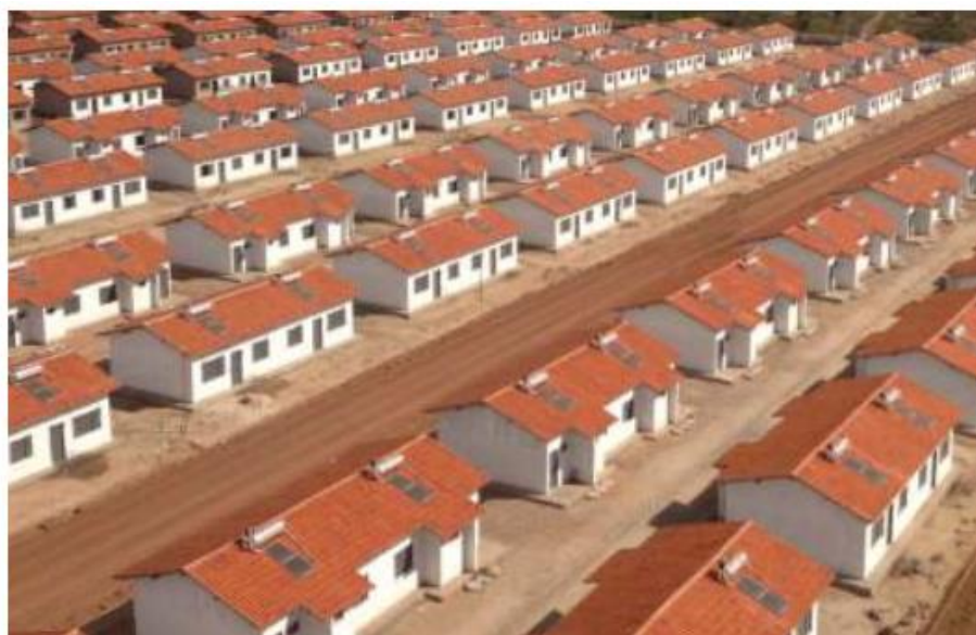
Figura 23 - Instalação de aquecedores solares em casas populares
