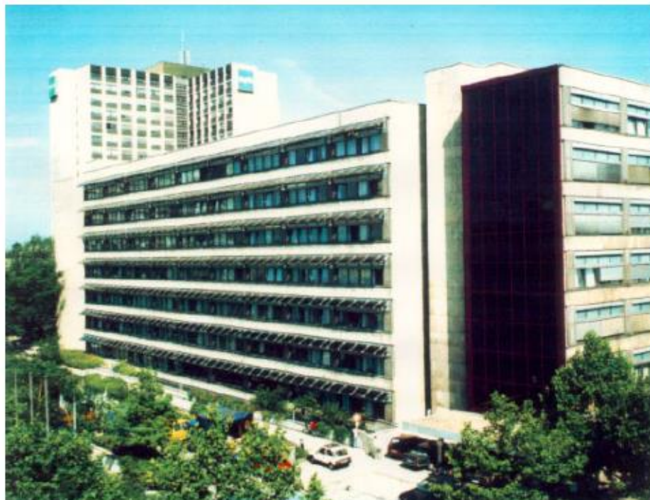
Figura 3.6 – Exemplo de aplicação de módulos solares em um edifício.
