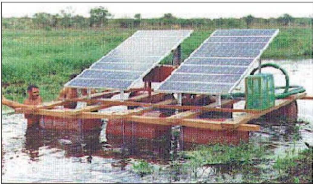
Figura 3.4 - Sistema fotovoltaico de bombeamento de água para irrigação.
