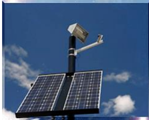
Figura 3.5 - Uso da Energia Solar Fotovoltaica utilizada para iluminação pública.
