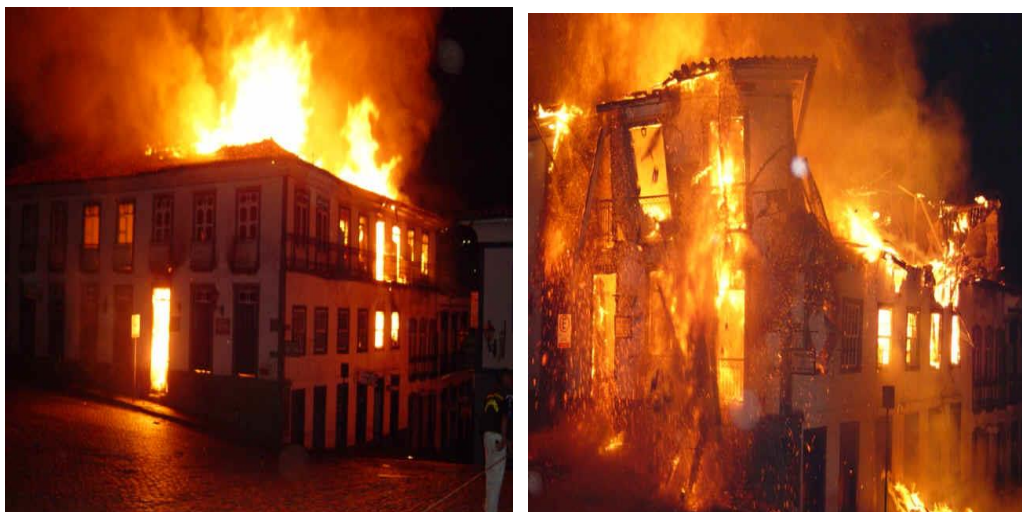
Figuras 23 e 24 –Incêndio no hotel do Pilão na Praça Tiradentes em Ouro Preto/ MG. Fonte: Labybe Maria. 230
