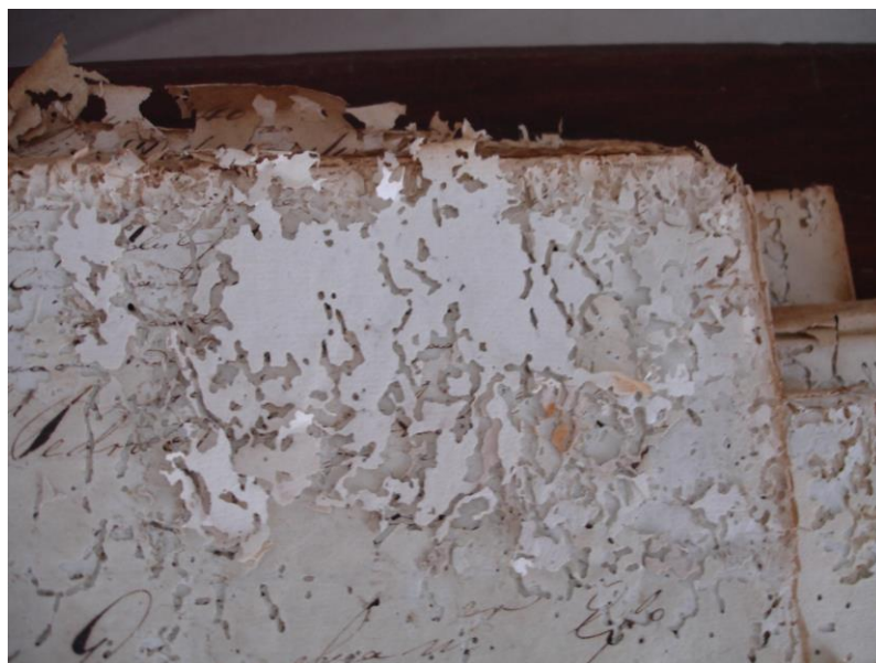
Fig. 11 – Ataque de Cupins no arquivo da Faculdade Integrada Paiva de Vilhena/ Capanha, MG. Fonte: Foto da autora.
