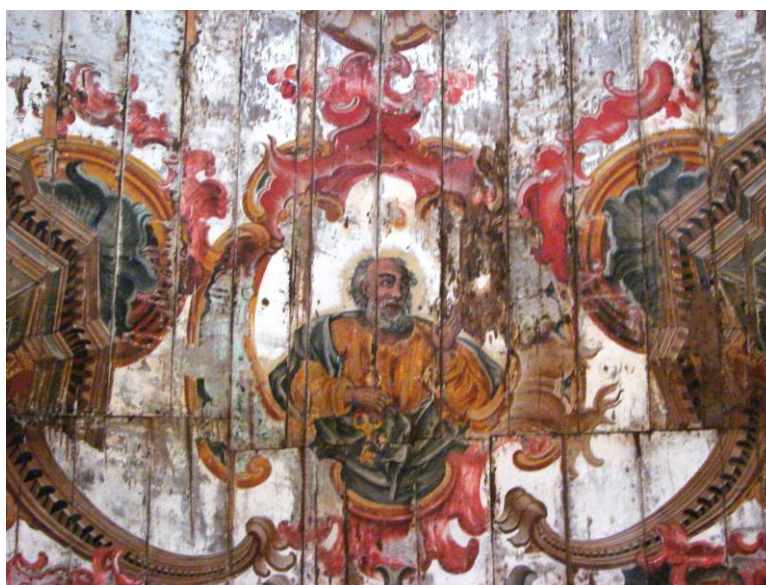
Fig. 9– Perda da camada pictórica ocasionada pela umidade no forro da Igreja do Rosário de Santa Rita Durão/ Mariana, MG Fonte: Foto da autora.
