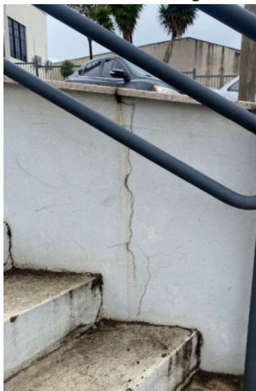
Figura 65 - Fissuras geométricas no revestimento cimentício.
