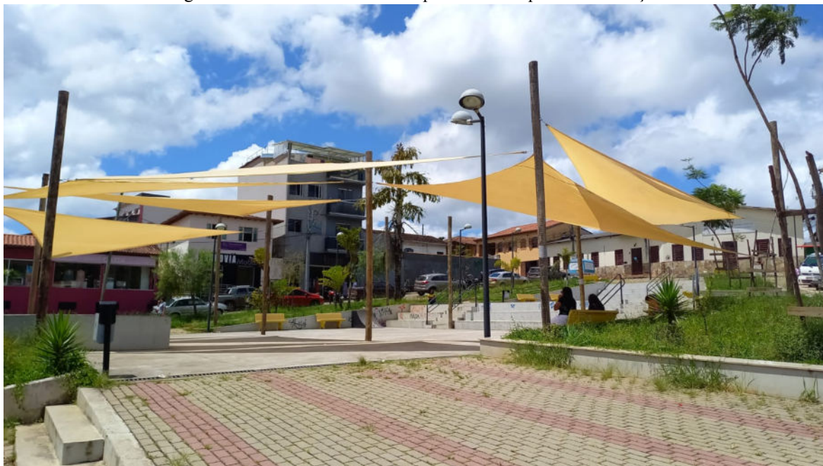
Figura 80 - Lonas tensionadas no primeiro dia após sua instalação
