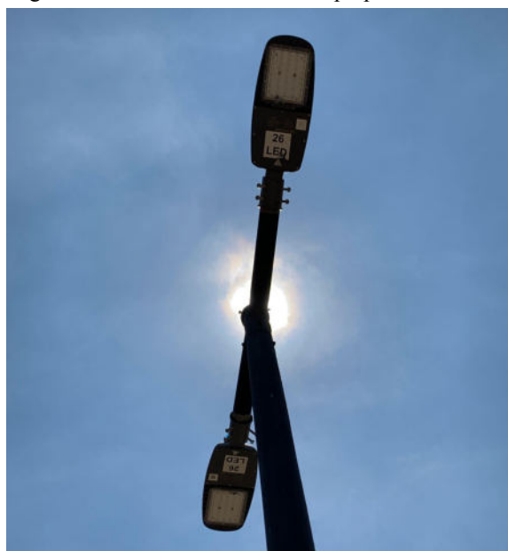
Figura 39 - Poste com luminária tipo pétala slim LED
