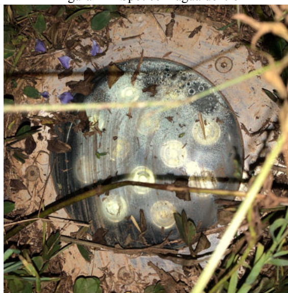
Figura 44 - Spot com água dentro
