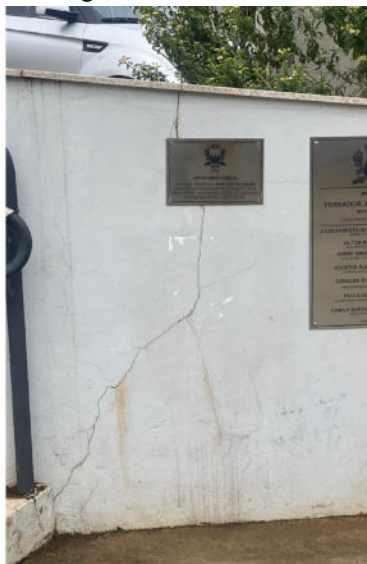
Figura 65 - Fissuras geométricas no revestimento cimentício.
