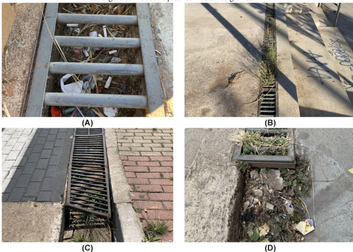
Figura 35 - Observações realizadas nas grelhas
