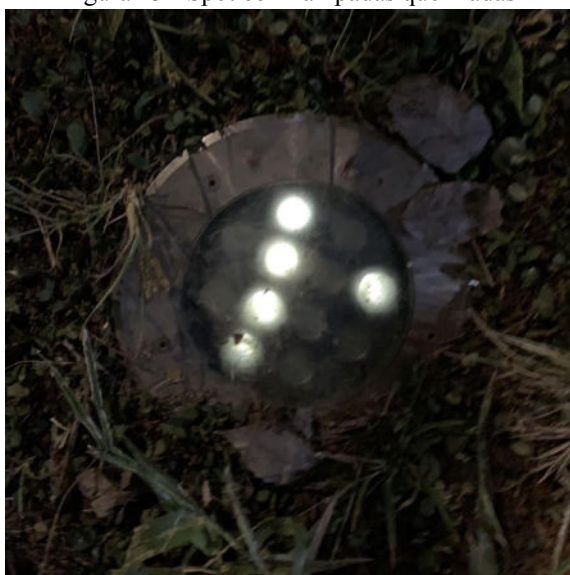
Figura 43 - Spot com lâmpadas queimadas
