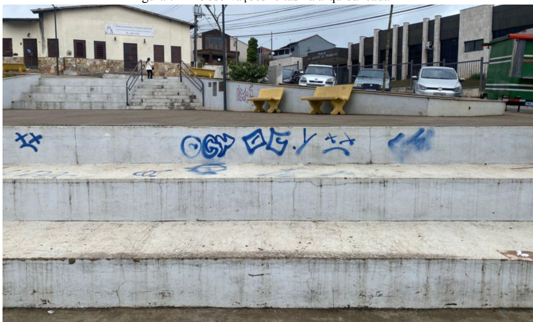
Figura 74 - Observações feitas na arquibancada A2
