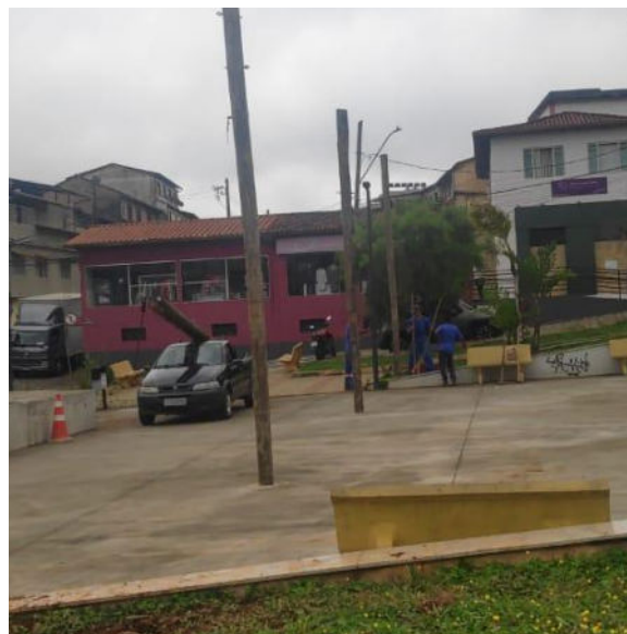
Figura 85 - Remoção dos postes de eucalipto
