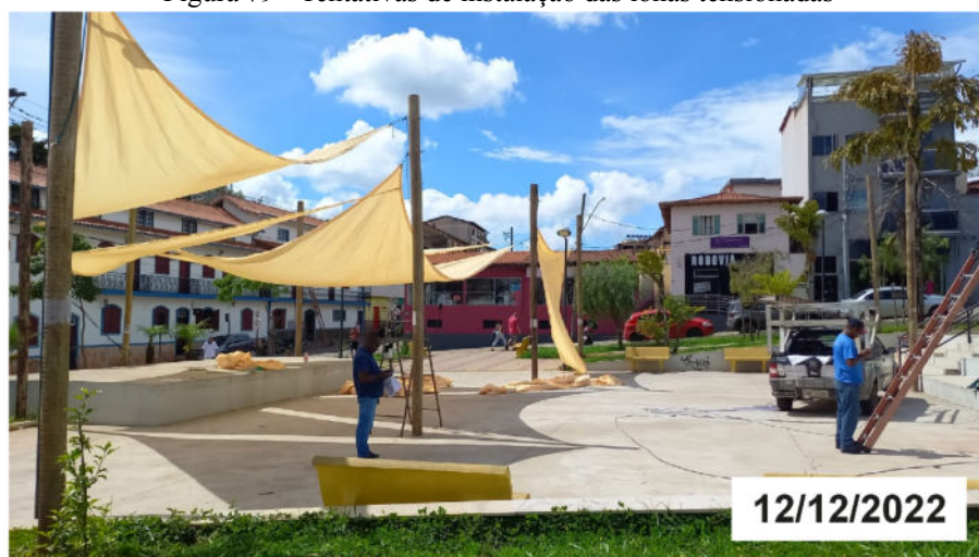
Figura 79 - Tentativas de instalação das lonas tensionadas
