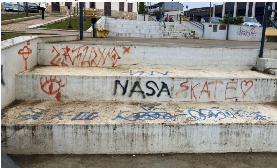
Figura 73 - Observações feitas na arquibancada A1
