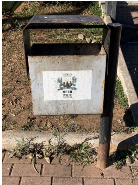
Figura 33 - Ferrugem e sujeidade na lixeira
