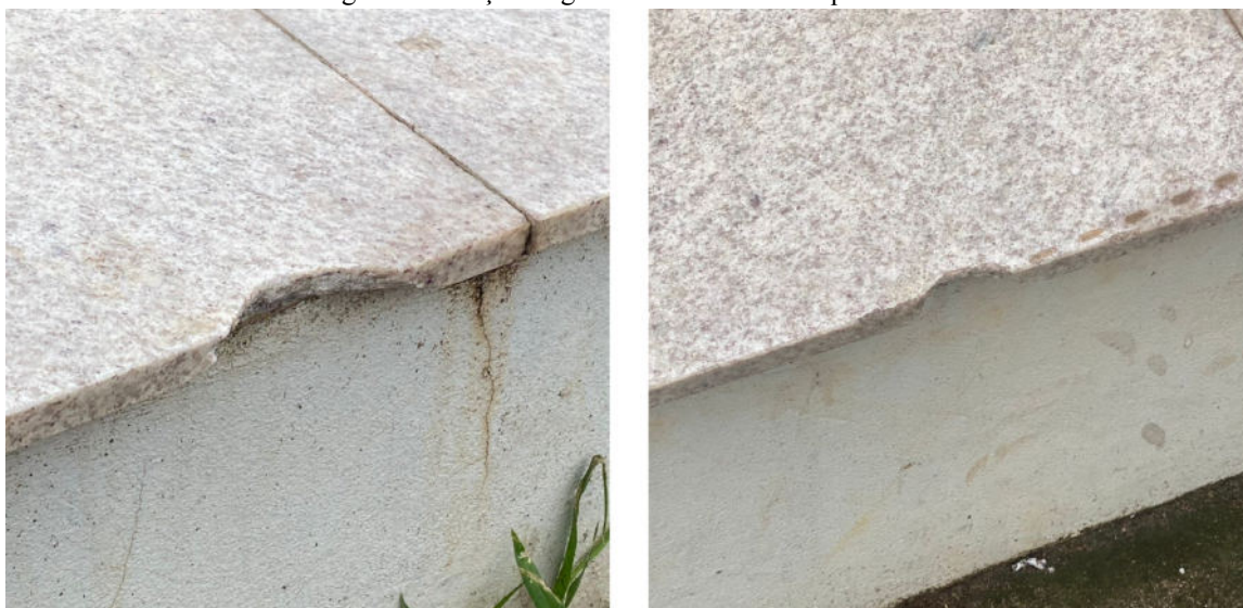
Figura 66 - Peças de granito com as bordas quebradas
