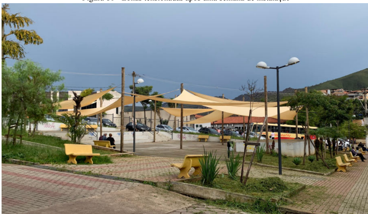
Figura 81 - Lonas tensionadas após uma semana de instalação
