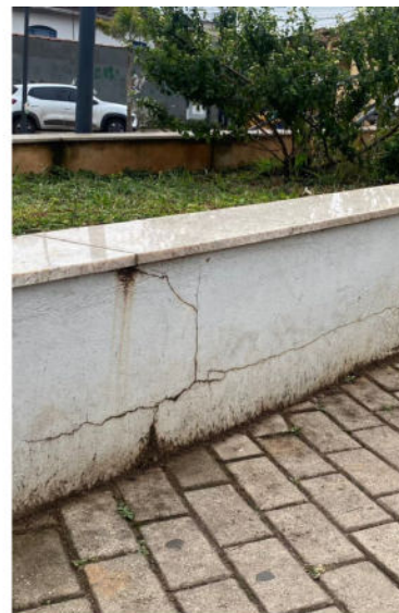
Figura 65 - Fissuras geométricas no revestimento cimentício.
