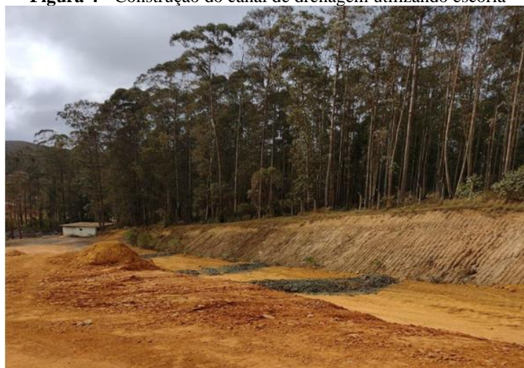
Figura 4 - Construção do canal de drenagem utilizando escória
