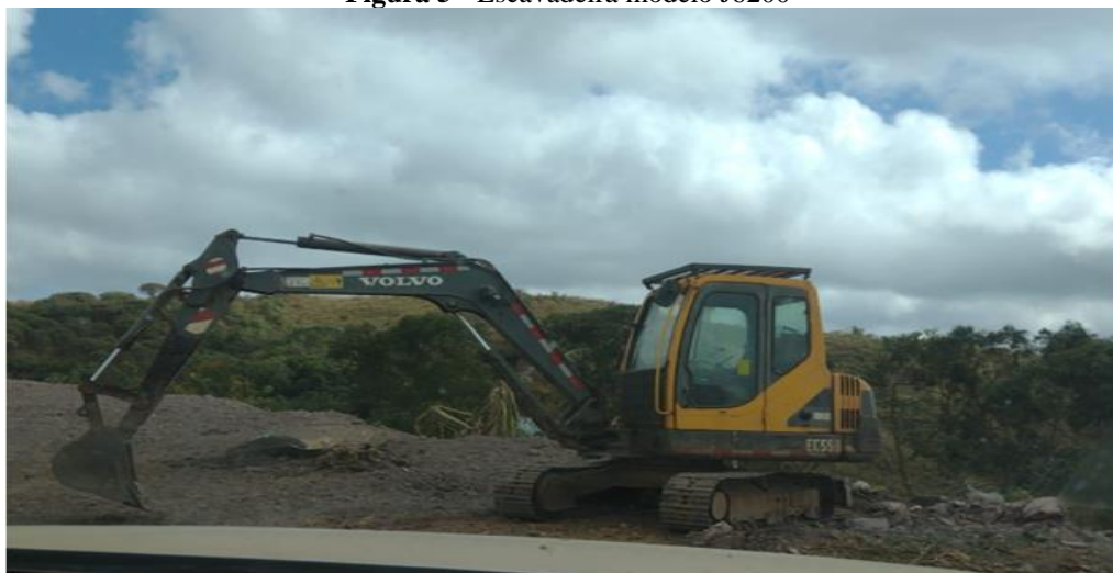
Figura 5 - Escavadeira modelo J6200
