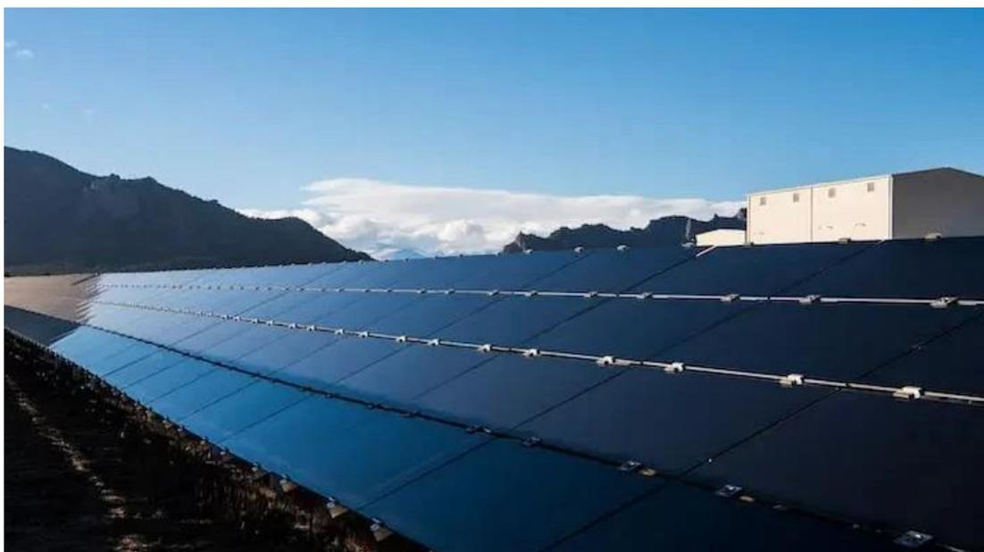
Figura 18 Módulos fotovoltaicos de telureto de cádmio
