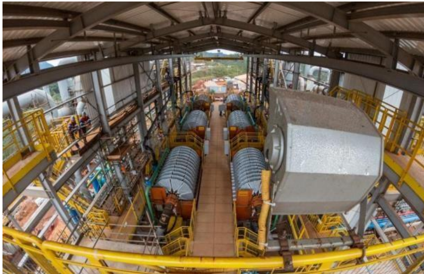
Figura 17 - Prédio de filtragem.
