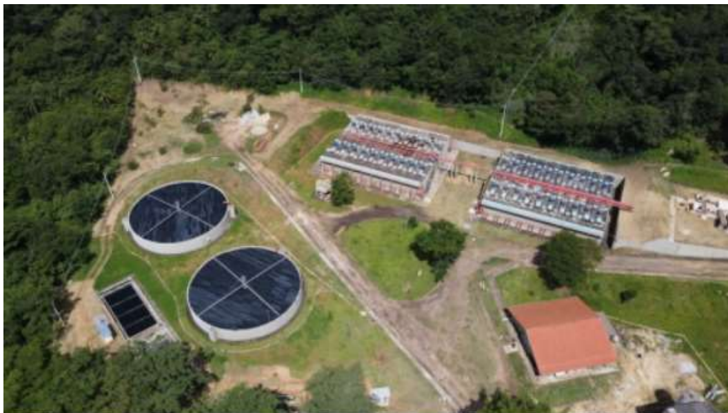
Figura 9 – Estação de tratamento de esgoto de Itaúna – MG
