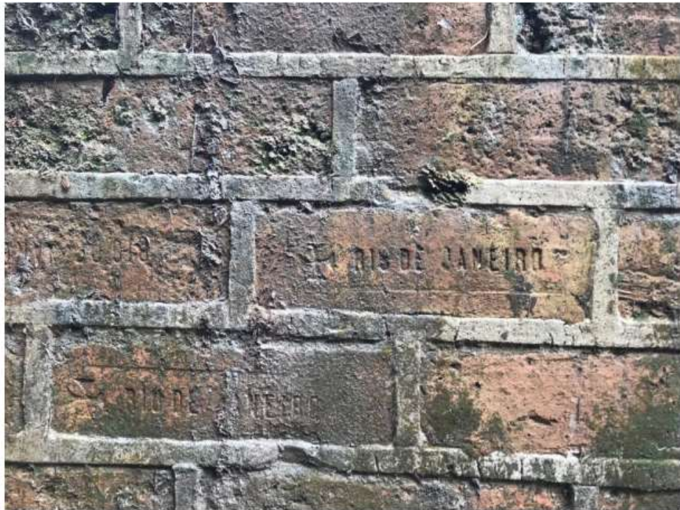
Figura 17: Tijolos do Rio de Janeiro utilizados nos tanque de desinfecção da Barra
