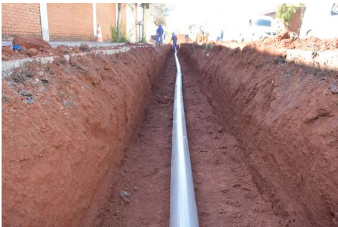
Figura 3 – Adutora de PVC em troca de rede de SAA no município de Lençóis Paulista – SP
