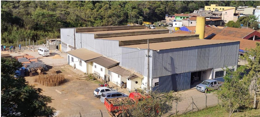
Figura 2: Vista da lateral direita e frente do galpão
