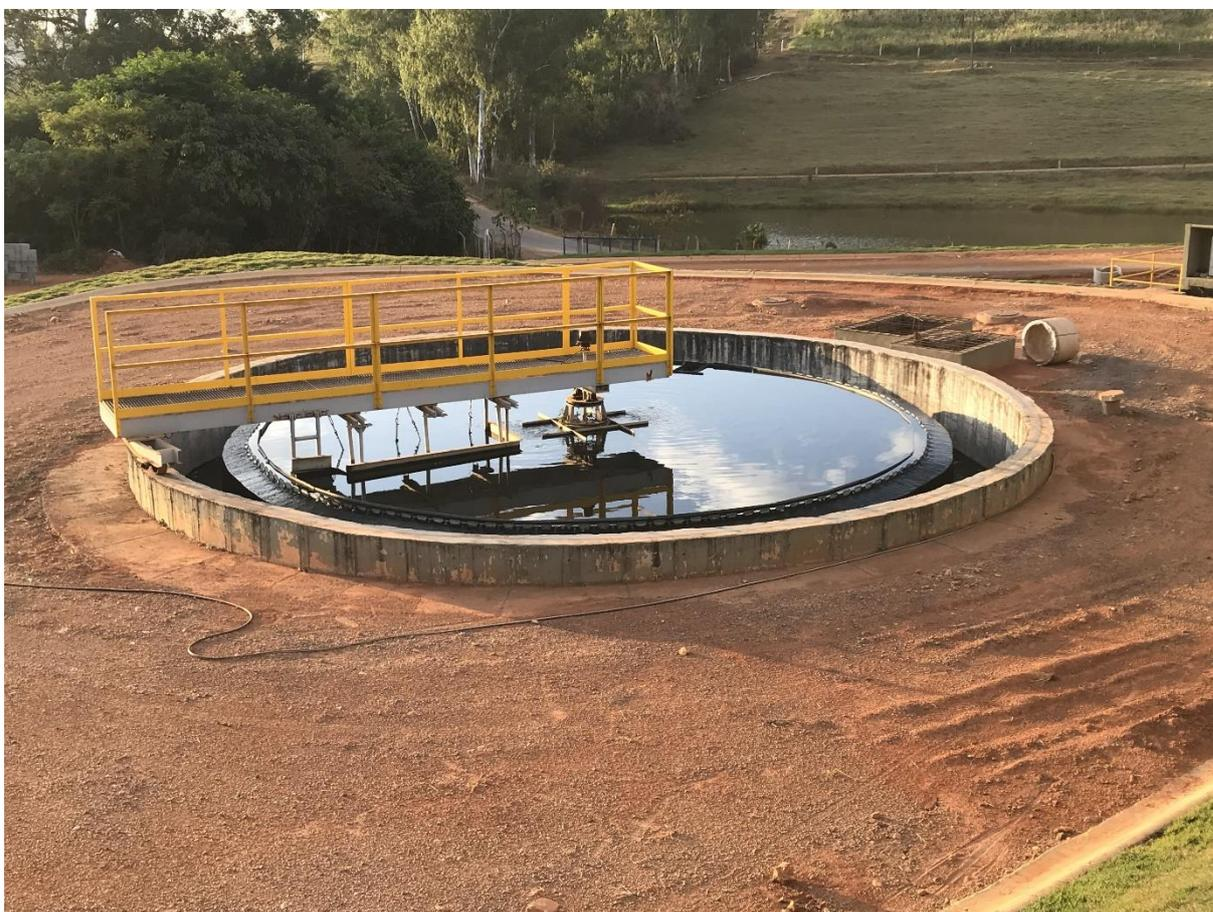
**Figura 10:** Decantador por pás. Fonte: autor.
