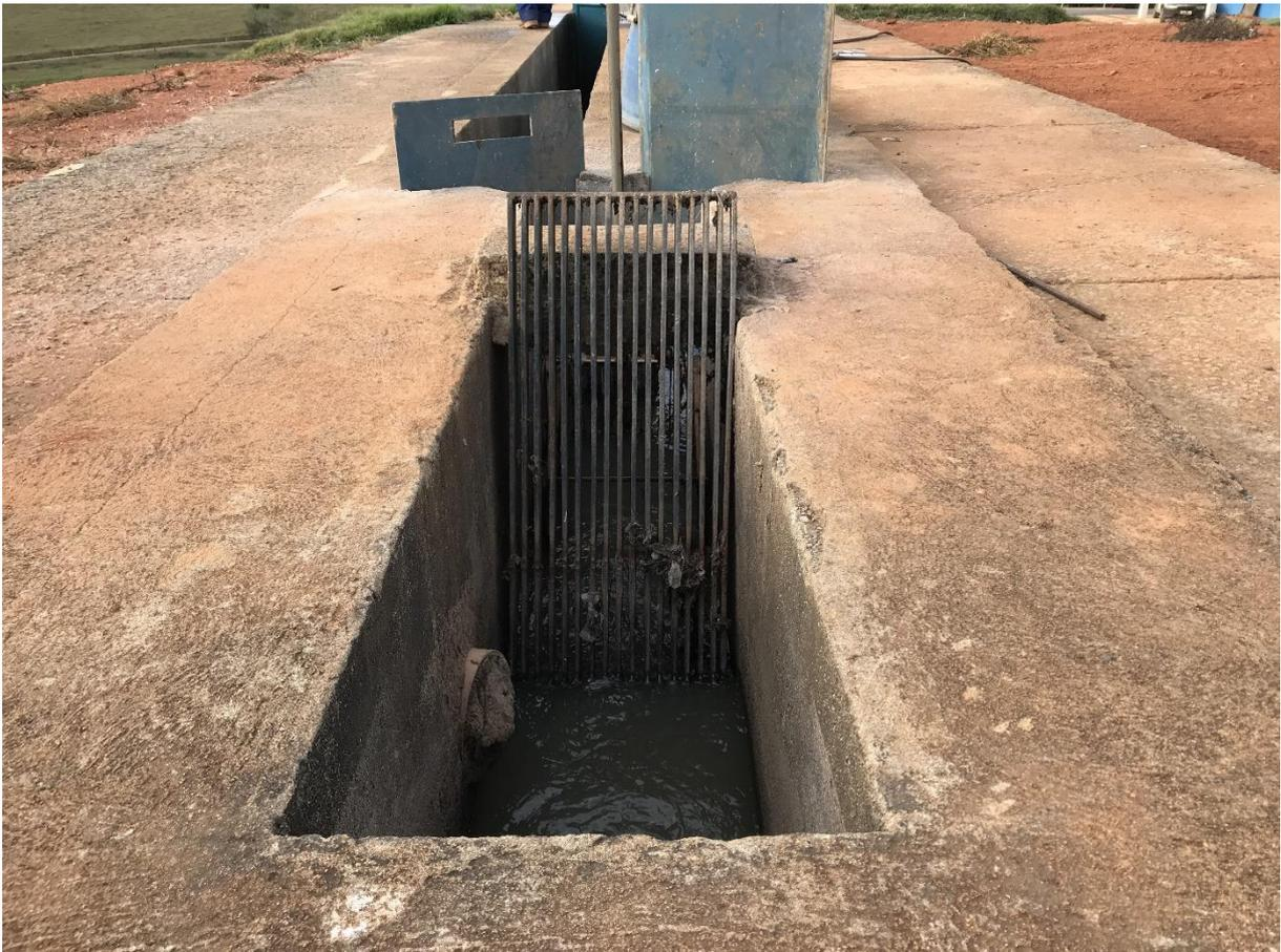
**Figura 5:** Grade utilizada no tratamento preliminar da ETE, foto tirada durante a visita técnica
