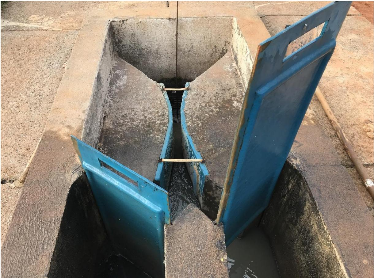
**Figura 7:** Medidor Parshall da ETE.
