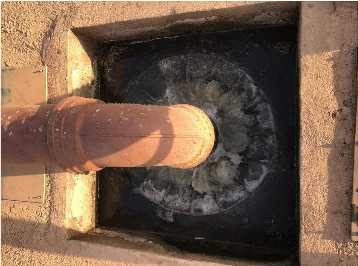
**Figura 13:** Tomada de esgoto do reator UASB, na foto é possível perceber a presença intensa de resíduos sólidos. Fonte: autor.
