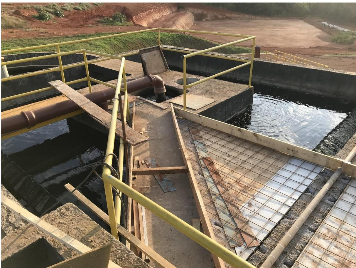
**Figura 8:** Unidade 1 do reator UASB, foto tirada durante a visita técnica. Fonte: autor.
