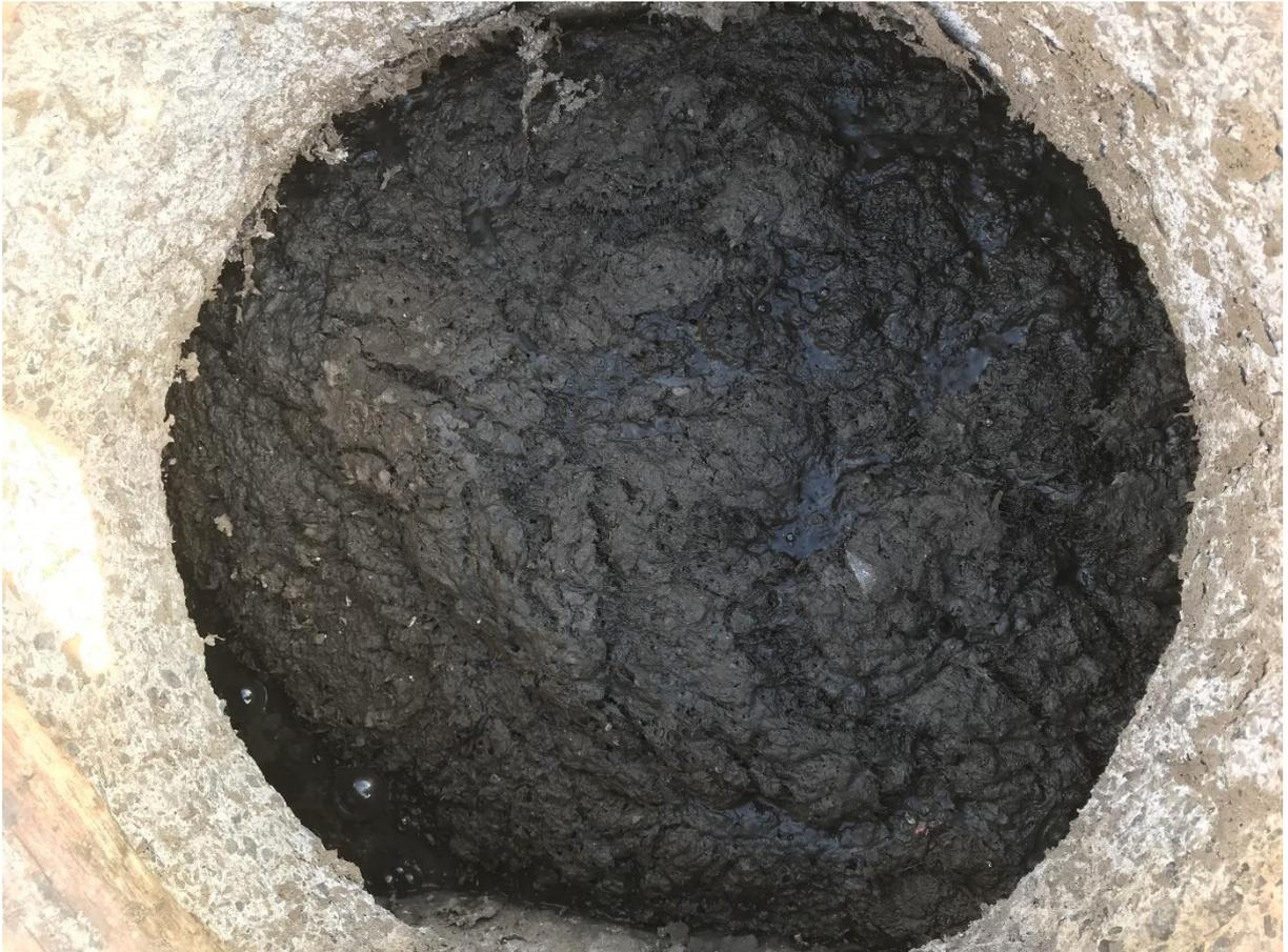
**Figura 15:** Poço de inspeção e manutenção do reator UASB, presença massiva de resíduos sólidos. Fonte: autor.
