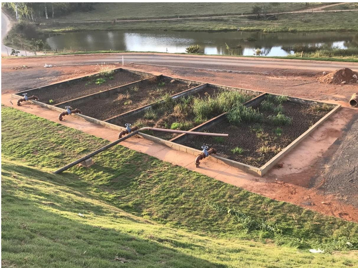
**Figura 11:** Leitos de secagem, totalizando uma área de 117,26 m<sup>2</sup>. Fonte: autor.
