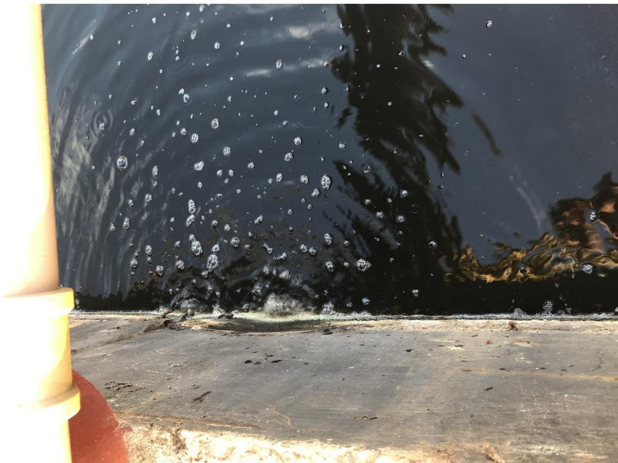
**Figura 14:** Presença de bolhas na interface da ligação concreto x separador trifásico.
