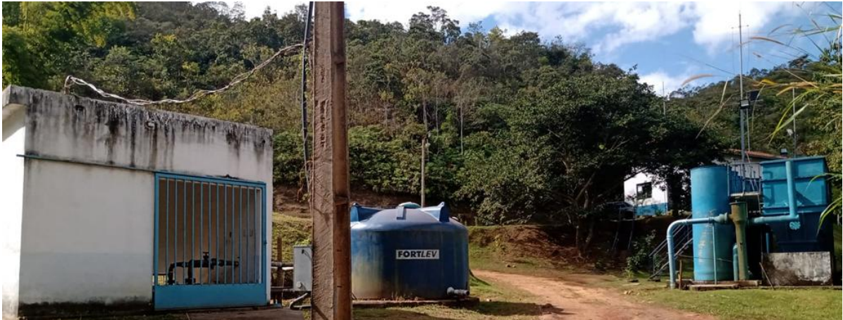
Figura 27: Panorama após finalização das modificações das instalações de bombeamento Fonte: Pesquisa direta (2021)
