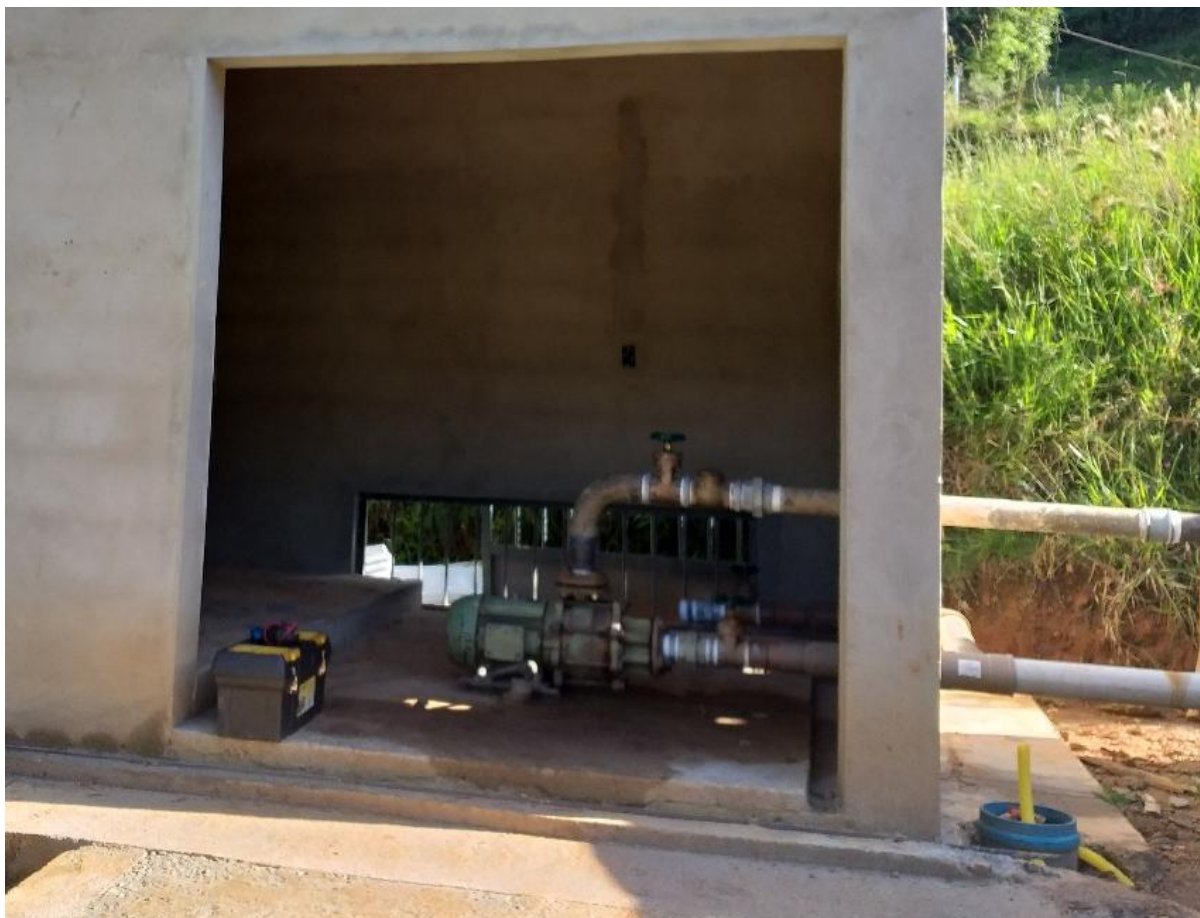
Figura 26: Modificação estrutural de uma estação elevatória Fonte: Pesquisa direta (2021)
