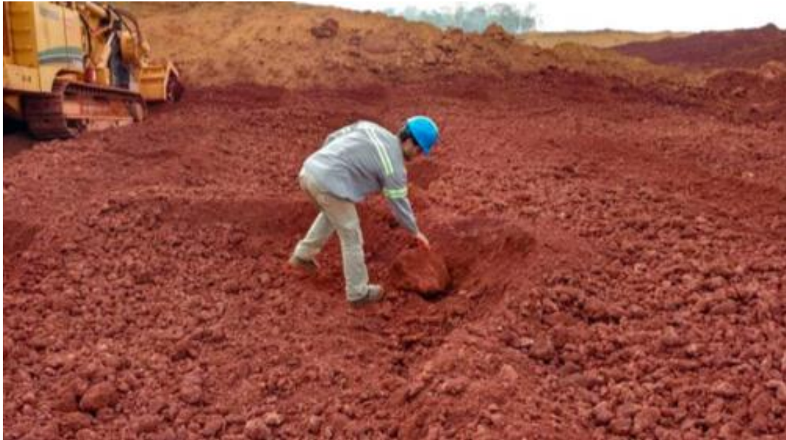
Figura 6.7. Ocorrência de blocos fora da especificação granulométrica (ALCOA, 2016)
