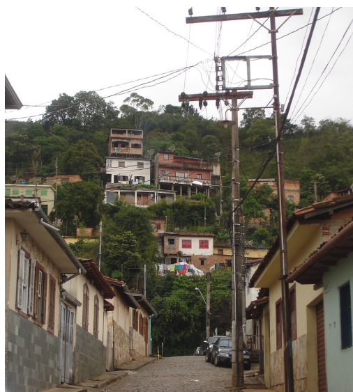
Figura 10- Ocupação desordenada das encostas da Serra de Ouro Preto - vista da Rua São Miguel Arcanjo, Água Limpa. (Foto da autora- 2010).
