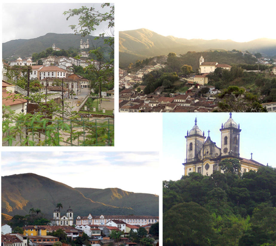
Figura 3- Preservação dos lugares de patrimônio e qualidade visual do espaço urbano. (Fotos da autora- 2010)
