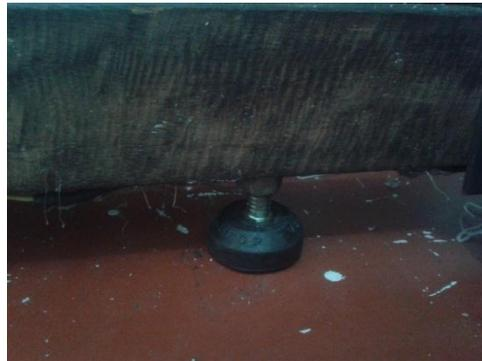
*Figura 6.3 – Pé adicionado a estrutura do eixo Y*
